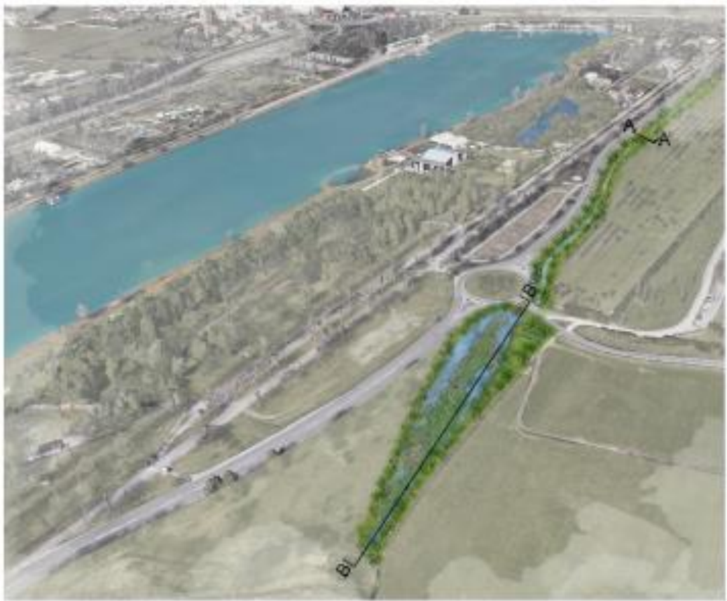
SEGRATE - VIA Mondadori - BACINO DETENZIONE NBS
